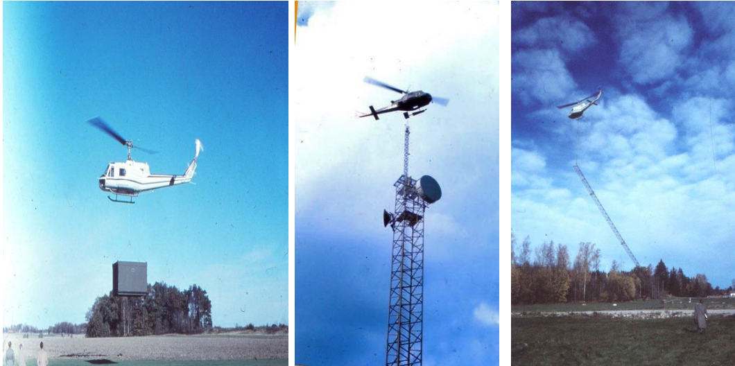
Exempel på helikopterlyft för radiolänk.
