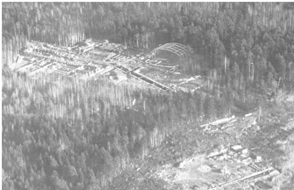
CFV under uppbyggnad 16 november 1926
