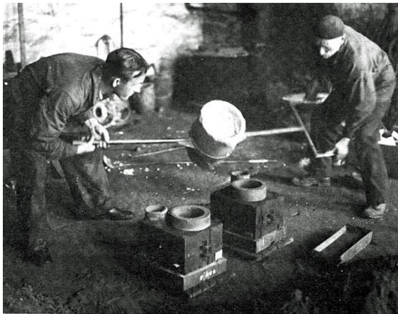
Gjutning av motorkolvar.
