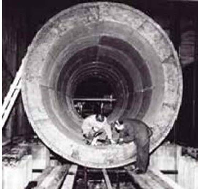
Ljuddämparen till provbocken
