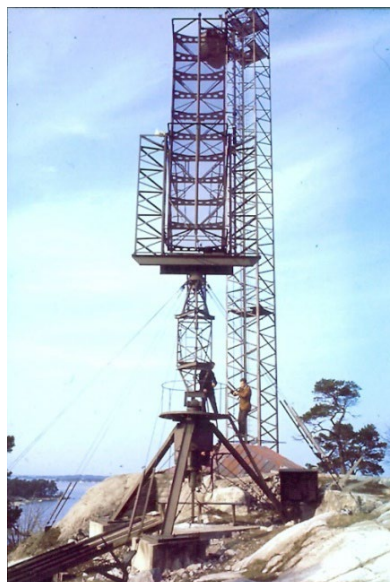
Radarstation PJ-21/F installeras, till vänster radar till höger höjdmätaren.
