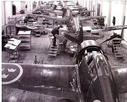
Montering av J 22 i P-tunneln
