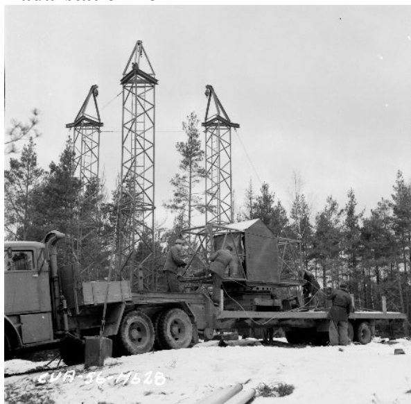
Radarstation PJ-21/F installeras, till vänster radar till höger höjdmätaren.
