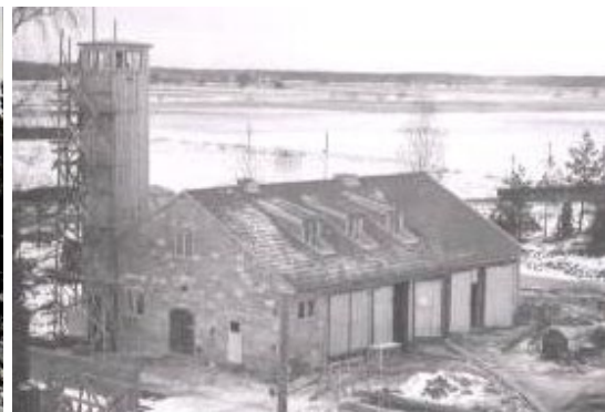
Brandstation och Garage.
