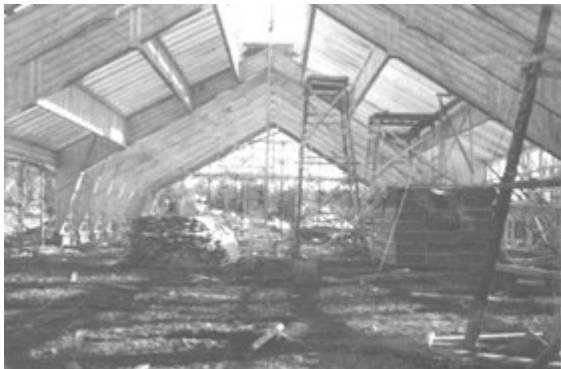
Monteringshallen uppbyggnad 9 mars 1944,
