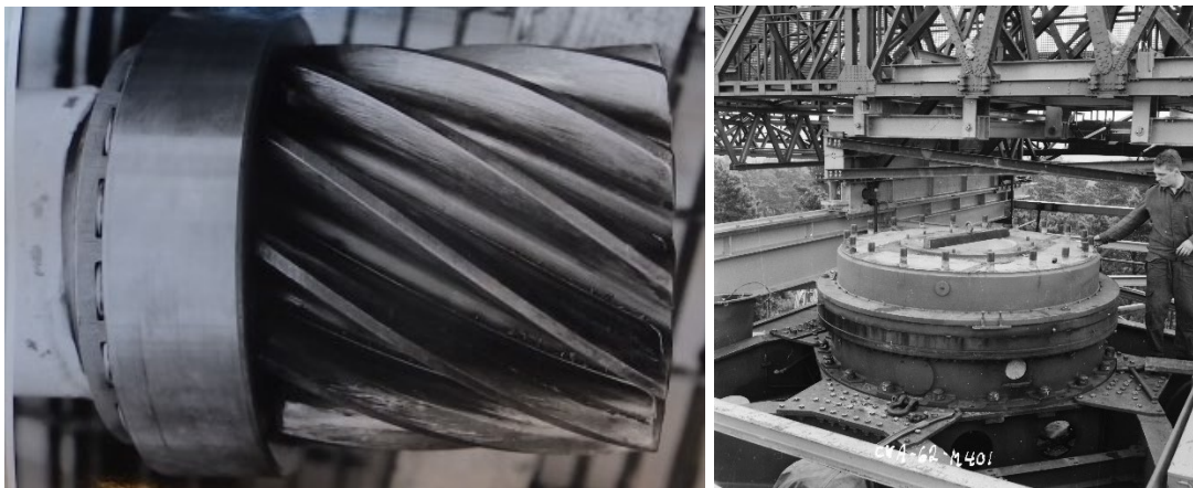
Vridbordsbyte, mekaniskt underhåll.
